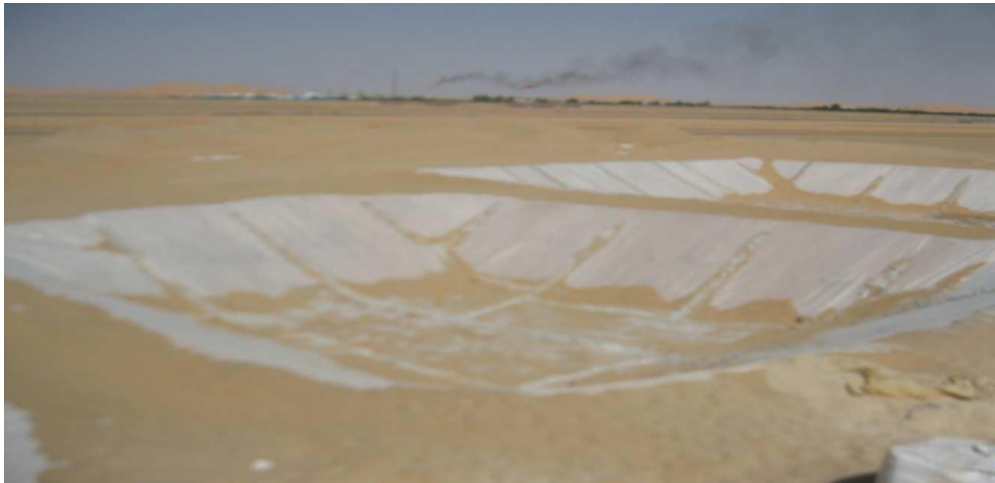
Photo III.1 : Bourbier étanche avant le forage (Hadj Abbas, 2011)
