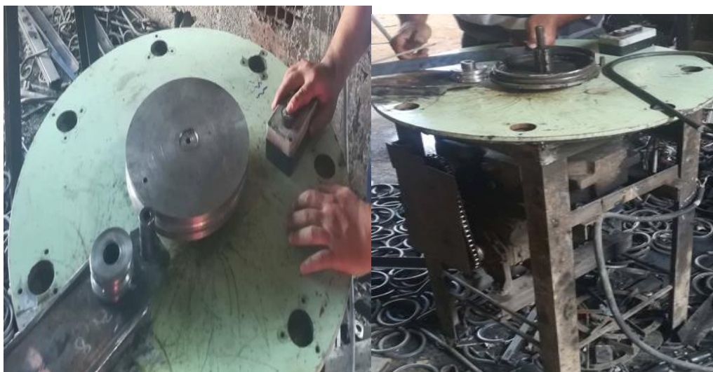
Fig. III.14: Réalisation du dispositif de cintrage
