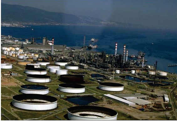
Figure 2.2: Vue partielle des réservoirs de la ferme de Tüpras, présentant les zones brûlées
