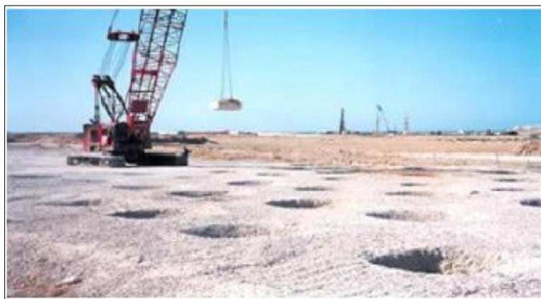
Figure 1.3 : Exemple de chantier de compactage dynamique (Document de Géopac et Ménard Sol traitement).
