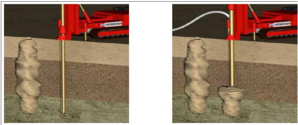
Figure 1.10 : Injection solide (Plates-formes pour amélioration des sols).
