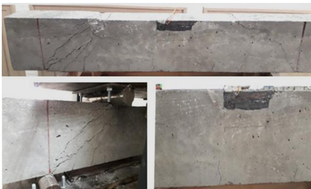
Figure 4. 3. Mode de rupture de la poutre contrôle (CB.1.U).
