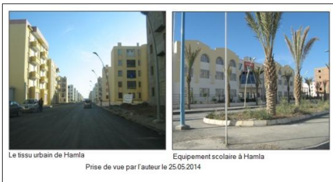
Photo II-22 : Vue sur le nouveau report de croissance Hamla
