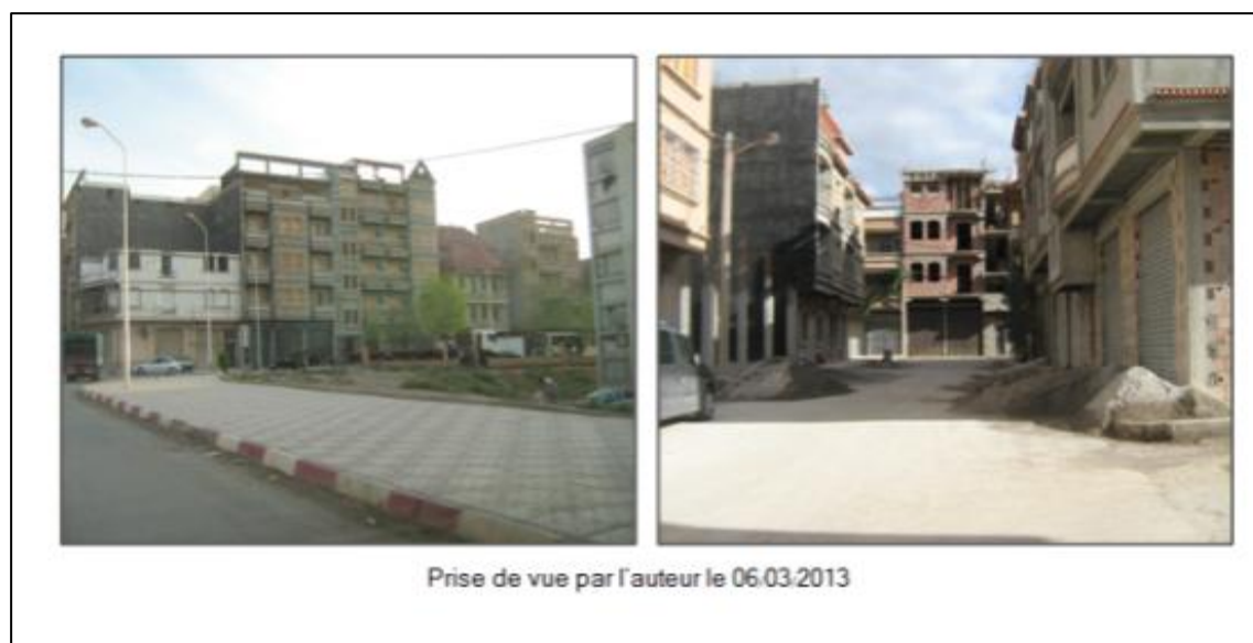
Photo II-19 : Villas de l'auto-construction, plusieurs niveaux d'habitation et des locaux Commerciaux au R.D.C,
