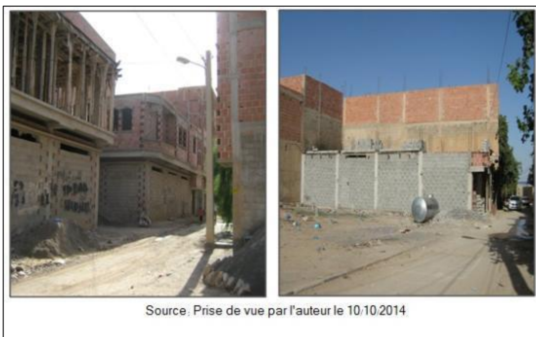
Photo VII-10 : Empiètement par le bâti des deux terrains réservés à l'édification de deux écoles primaires
