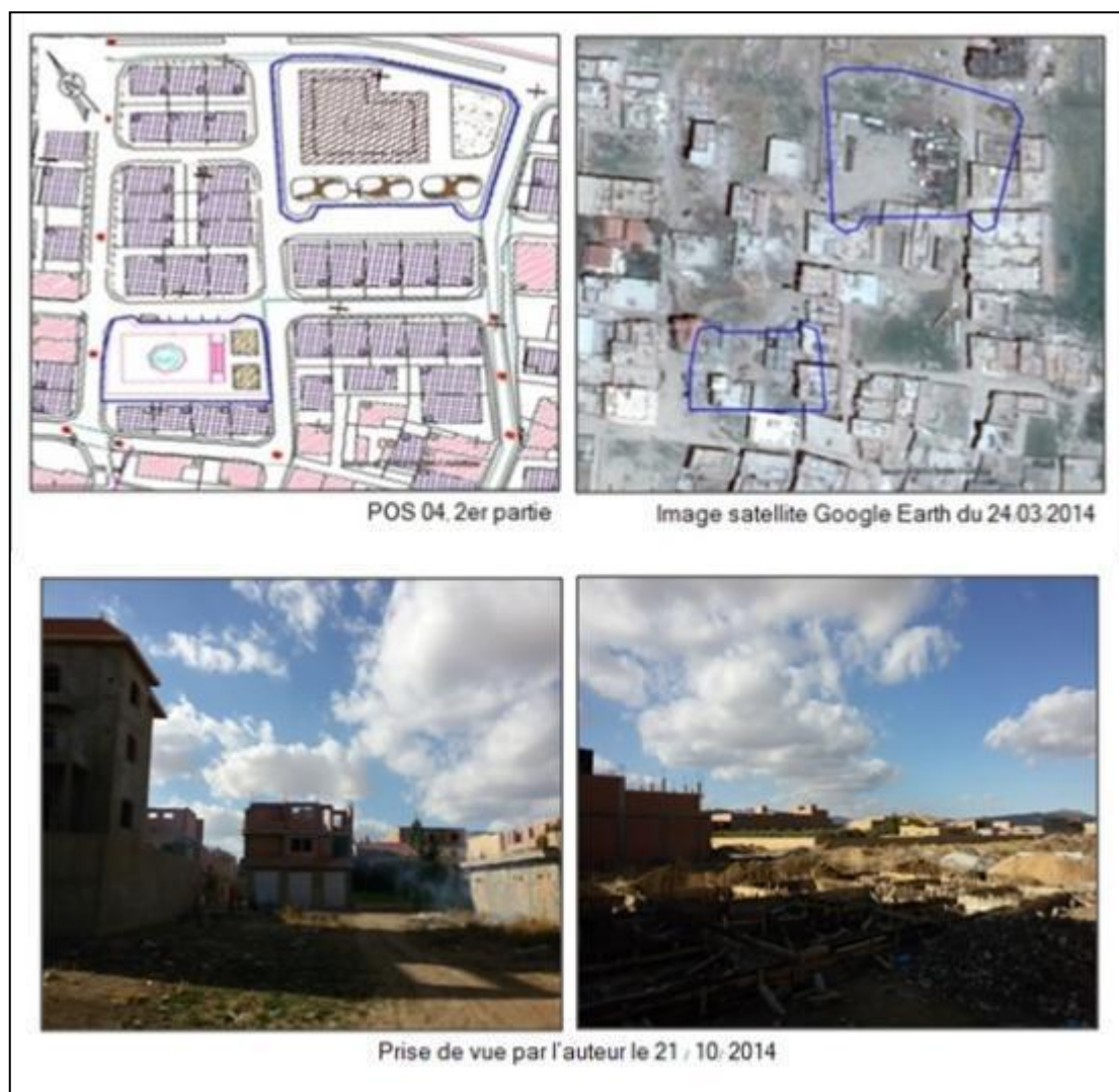
Figure VII-28 : Auto-construction sur la parcelle réservée à la construction de la mosquée à gauche et début d'empiétement sur la parcelle du centre commercial à droite
