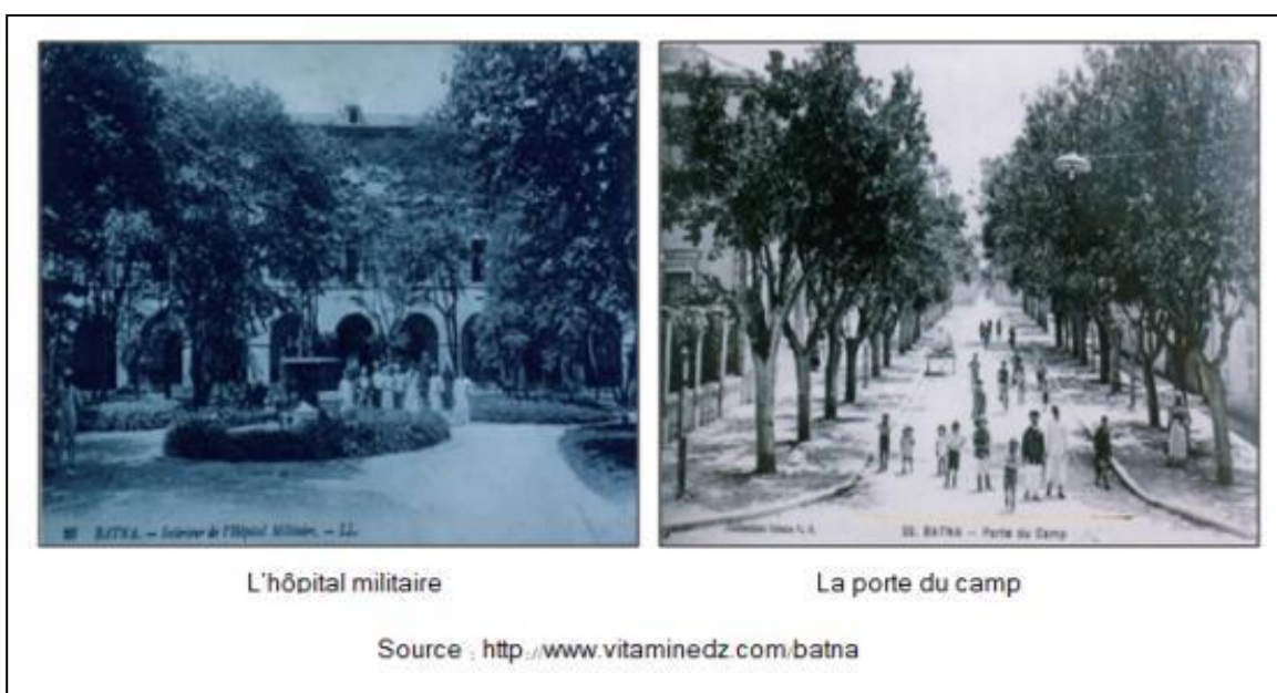
Photo II-5 : les édifices de la colonisation
