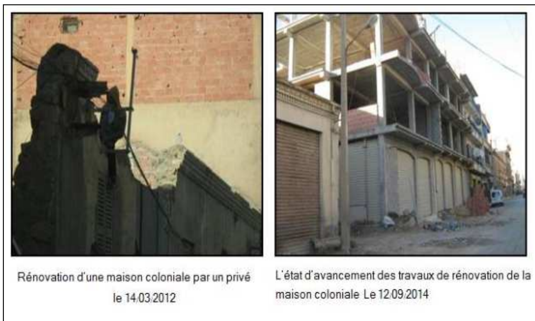
Photo VI-1 : Rénovation d'une maison coloniale par un privé au centre-ville de Batna
