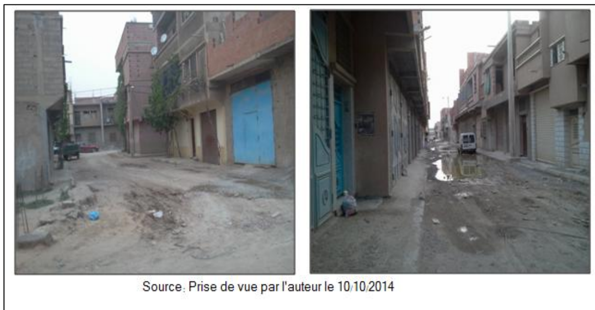
PhotoVII-6 : L'état des route, boueuses et sans trottoirs manque de réseau d'assainissement des eaux pluviales
