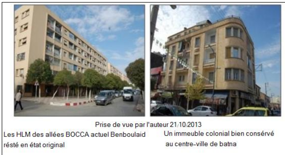
Photo II-10 : Les derniers immeubles coloniaux qui ont résisté aux changements
