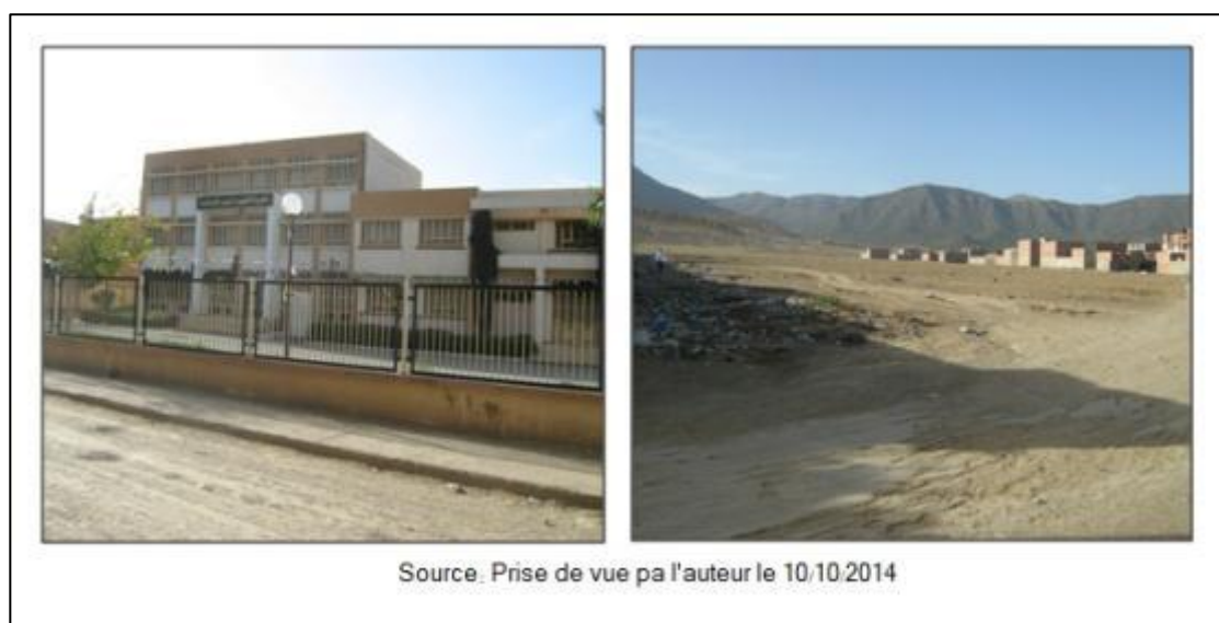
Photo VII-14 : Réalisation du lycée programmée, à proximité de projet d'habitat qui reste terrain vague
