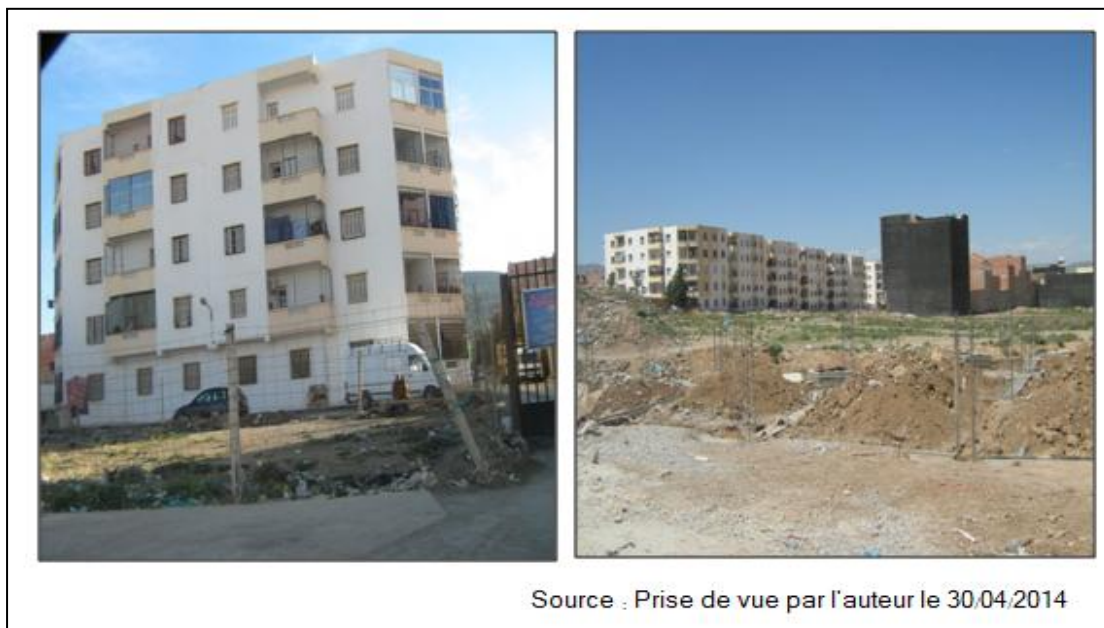
Photo VII-37 : L'unique ensemble d'habitats collectifs dans le POS 04 en forme de six bâtiments de quatre étages, alignés perpendiculairement à l'axe principal. Une promotion privée de type participatif du promoteur « BAGHDADI »
