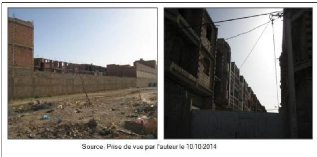
Photo VII-11 : L'emprise de l'hôpital à créer, est complètement occupée par le bâti
