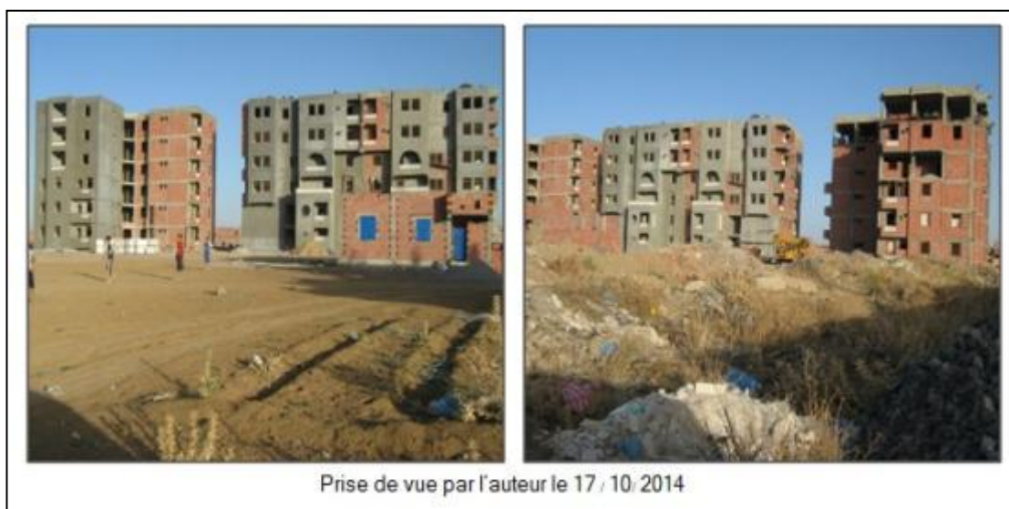
Photo VII-41 : Habitat collectif en construction, une promotion immobilière privée
