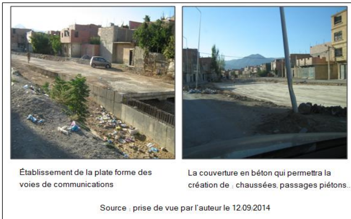
Photo VI-8 : Finition et achèvements des travaux de recouvrements des oueds
