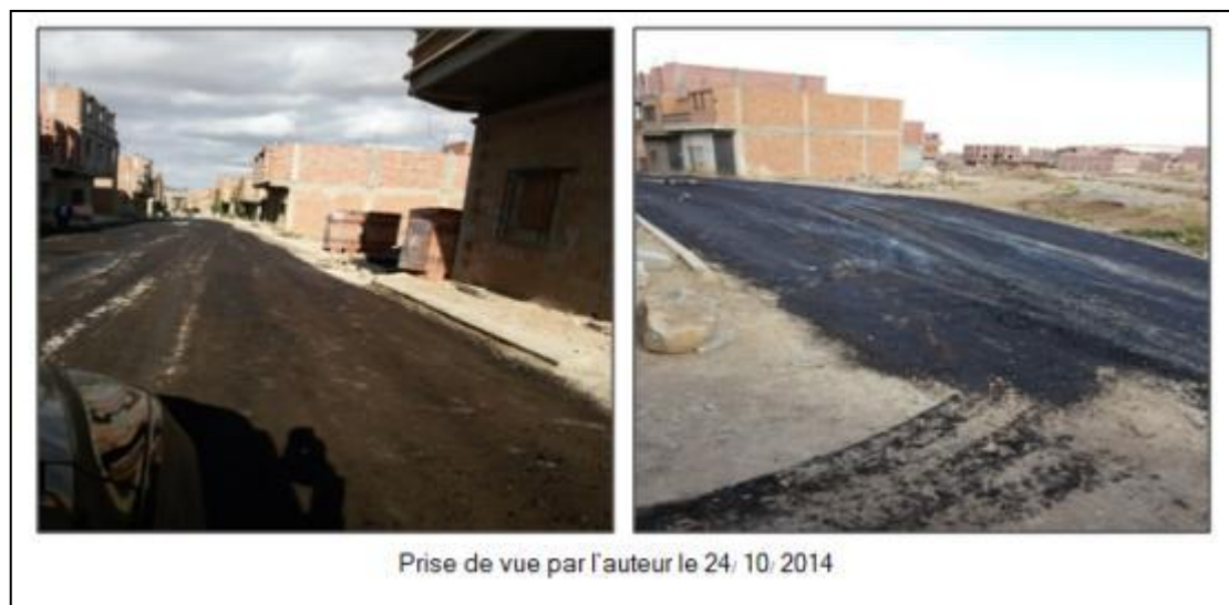
Photo VII-24 : Des voies tertiaires fraîchement bitumées
