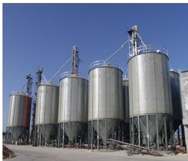
(d) Silo de stockage
