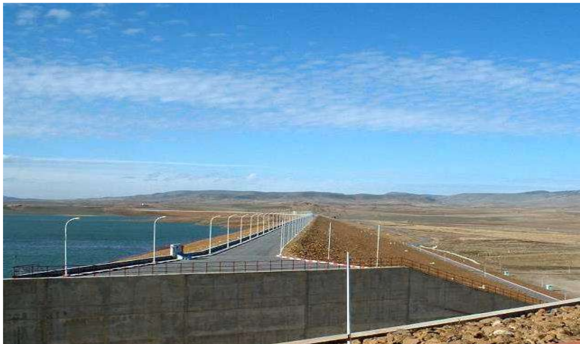
Figure V.5 : Photo Représentative de la tour de prise et la vidange de fond du barrage Koudiet Medaour (Source : ANB, 2005)
