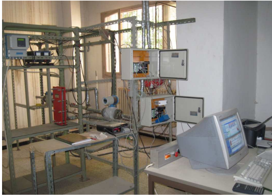
Fig.5.4 : Vue du banc de tests du système de production d'eau chaude par énergie solaire.
