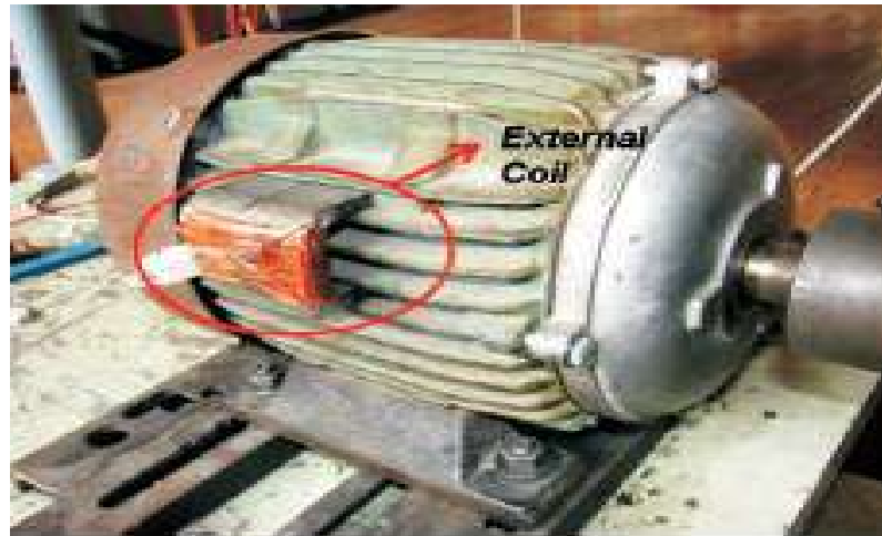
Figure II.1 : L'utilisation de bobine externe pour la détection de saillance
