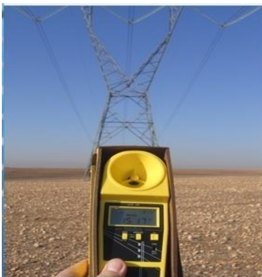
Figure V.44 Mesure de la hauteur entre le sol et le conducteur de phase
