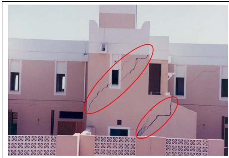
Figure II.3 : Dommages structuraux dus au soulèvement de terrain à Al-Khod Oman
