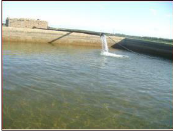
-Bassin d'accumulation des eaux pompées d'un forage bénéficié dans le cadre du PNDA-
