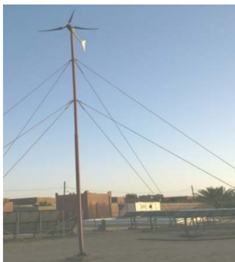
Figure I.8. Turbine éolienne à base MSAP, URERMS, à Adrar.
