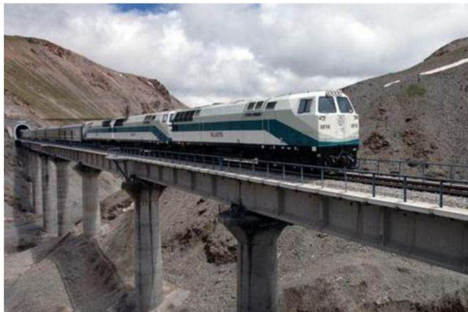
Figure 1.2 L'entrée du plus long tunnel au monde de la montagne Kunlun (Wong, 2015).
