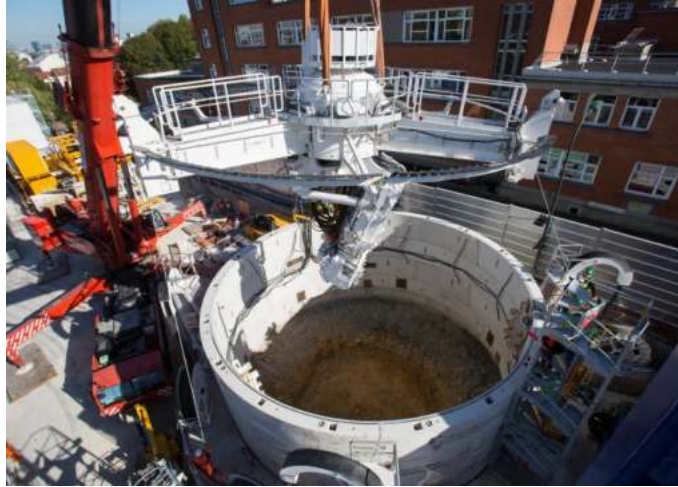
Figure 1.20 Tunnelier vertical de la société Grand Paris, France (Delaporte, 2018)
