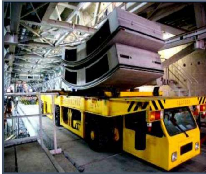
Figure 1.24 Transport de segments dans le tunnel.
