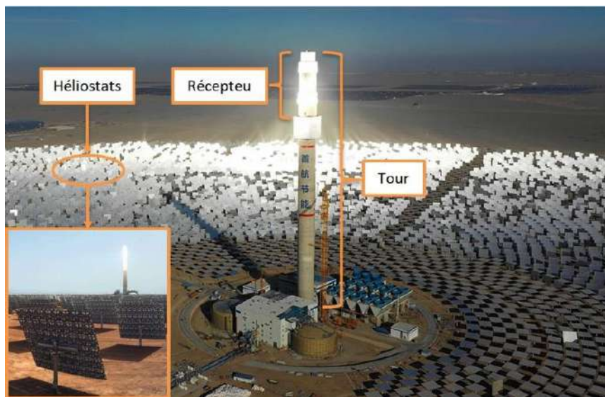
Figure 1.2. Centrale solaire à tour.
