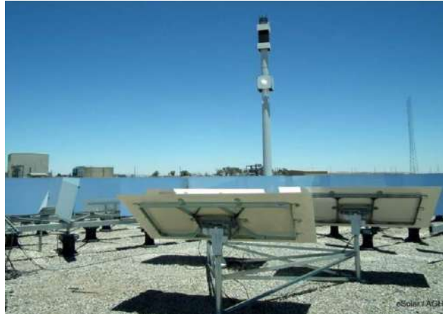
Figure 1.20. Héliostats SCS5 de 2 m 2 [43].
