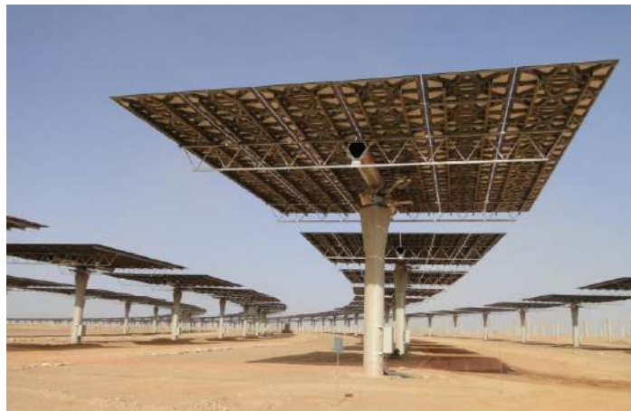
Figure 1.18. Héliostat de SENER de 175.7 \text{ m}^2 [41].
