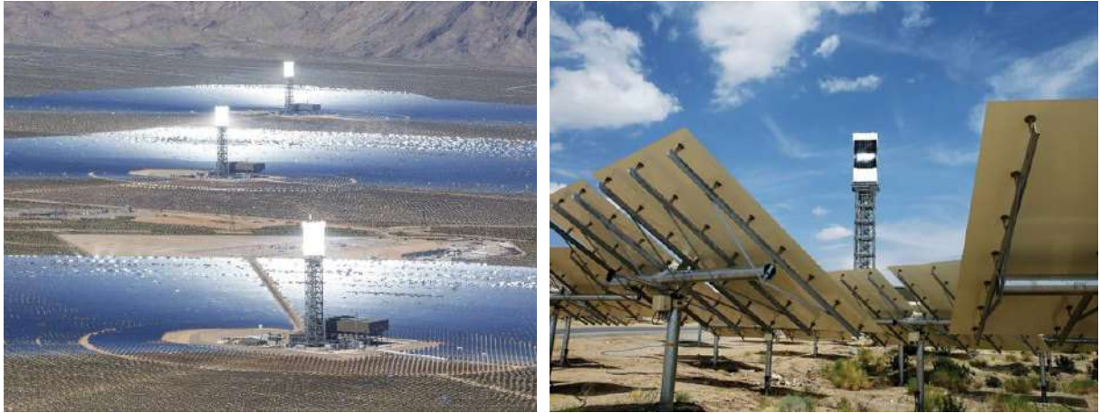
Figure 1.8. Centrale solaire à tour Ivanpah.
