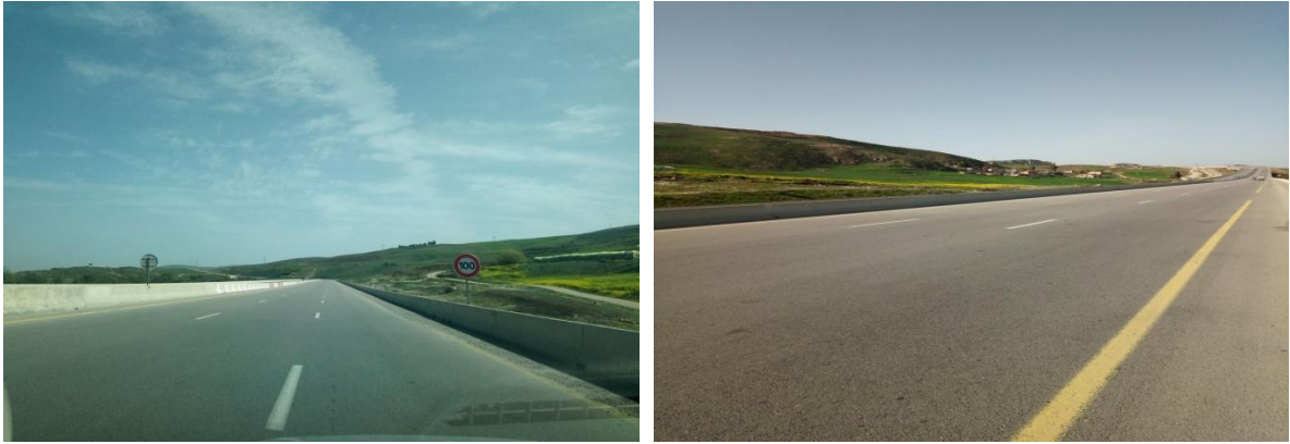
Figure 6.36 La section de l'Autoroute en question après la mise en service
