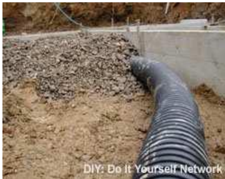
Figure 1.19: Drains encastrés autour des structures.
