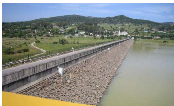
Photo 5.3. La digue du Barrage Cheffia. (cliché :CH.bouhadeb, 2016)
