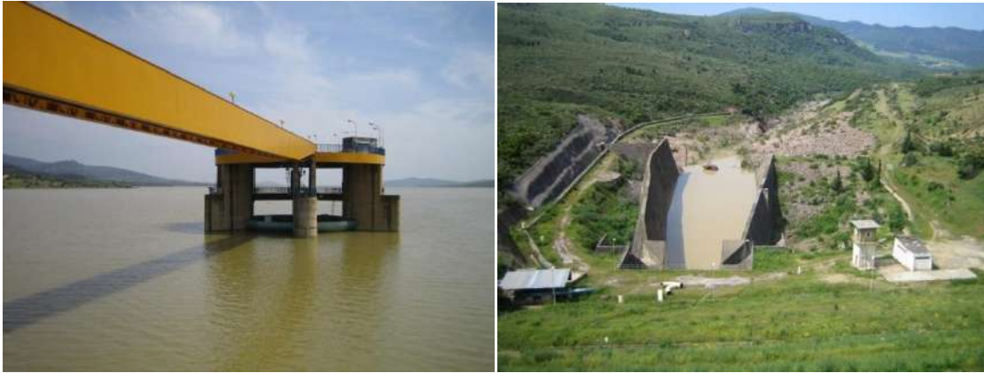
Photo 5.5. Evacuateur de crues. (cliché :CH.bouhadeb, 2016)
