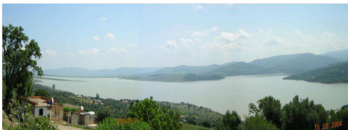
Photo 5.1. Réservoir du barrage CHEFFIA. (cliché :ANBT, 2004)
