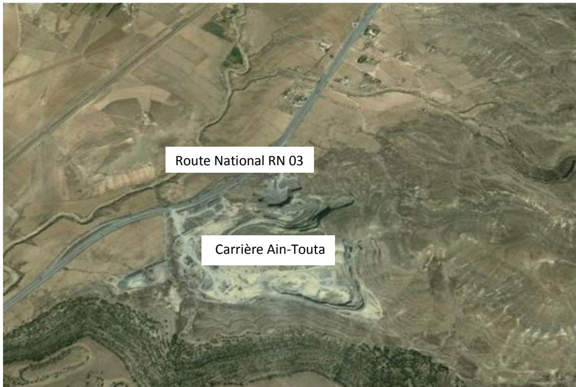
Figure 2: Photo Satellite de la carrière Ain-Touta.
