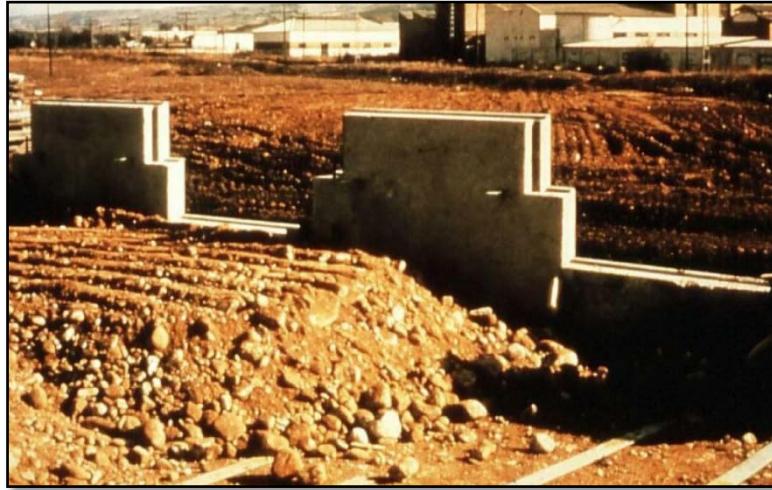
Figure I.11 mur en terre arme. [40]
