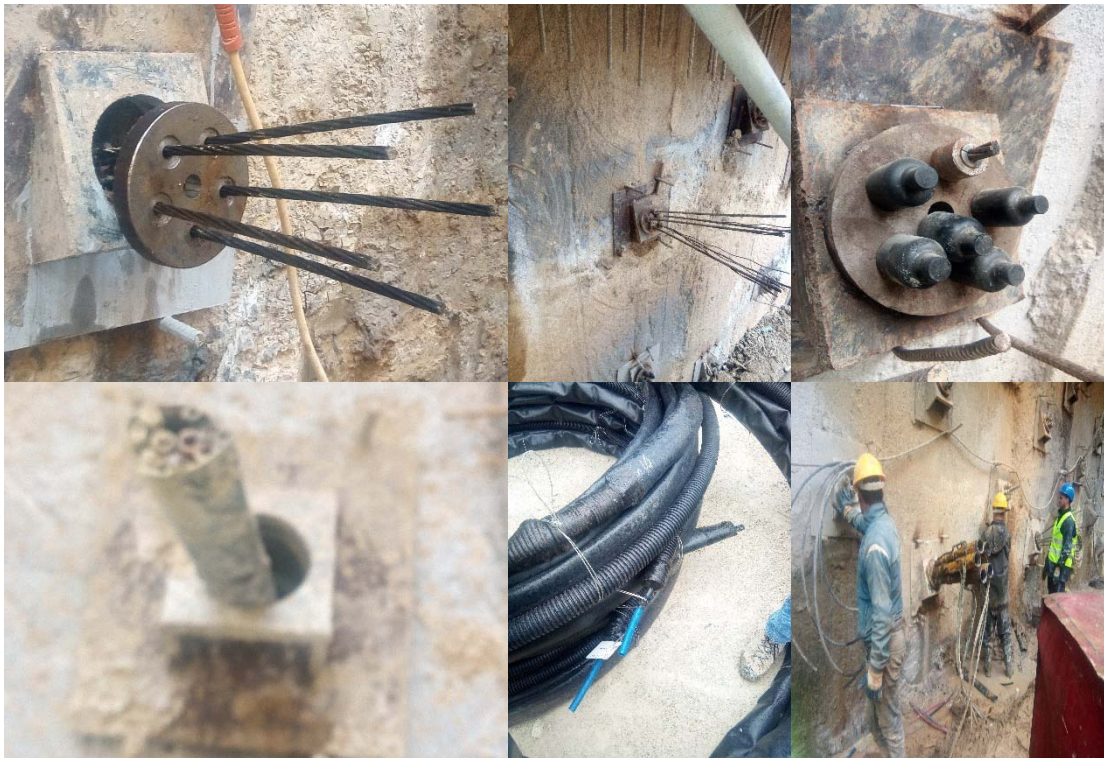
Figure IV.6 Présentation tirants d'encrages. (Cas station Oued Smar)
