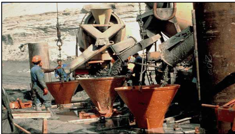
Figure I.12 Les murs en parois moulées. [30]
