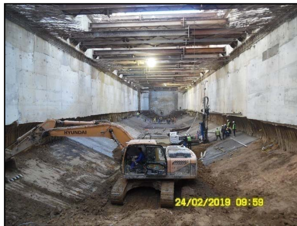
Figure I.13 Photo de paroi moulée (Station Oued Smar)
