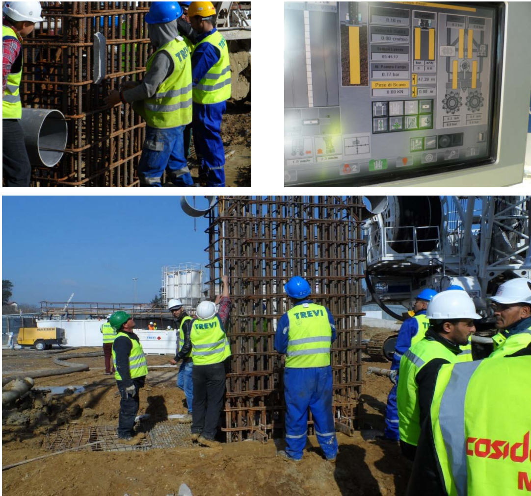
Figure I.16 Les photos d'exécution d'une paroi moulée (Station Oued Smar).
