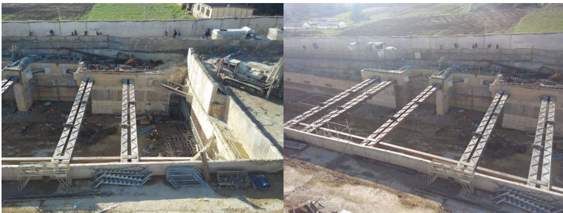
Figure II.8 Butons de soutènements
