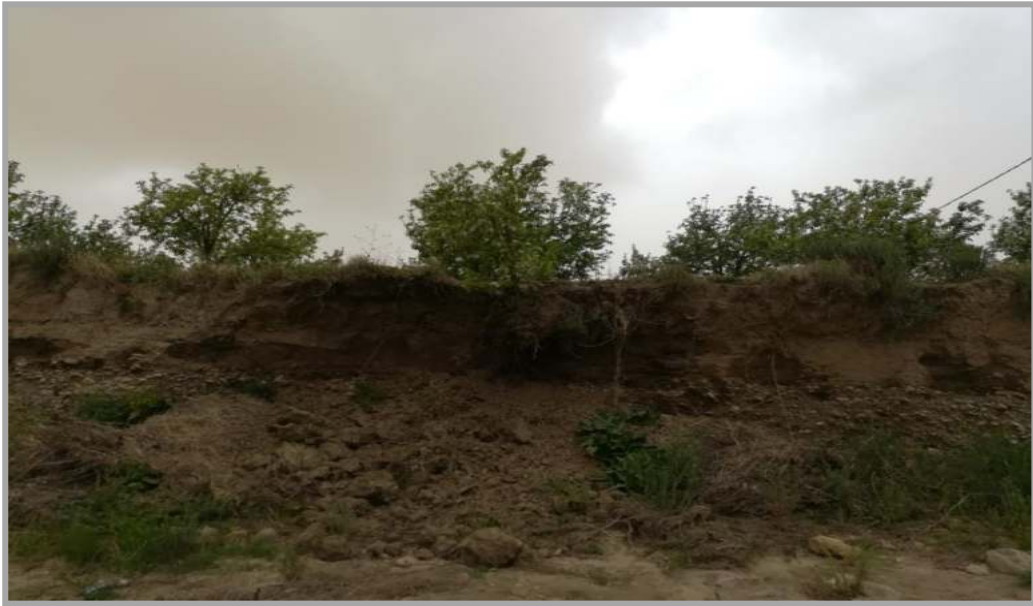
Photo 15 : Effondrement et sapent des berges (Oued Al Arab)
