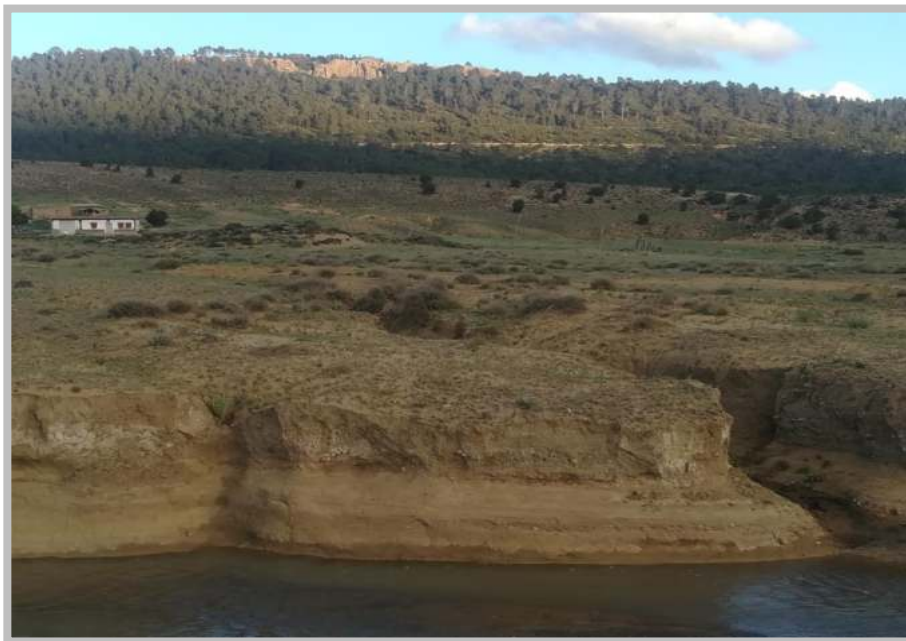
Photo 16 : Oued Al Askeur : Formations alluviaux-colluviales affectée par l'érosion régressive.
