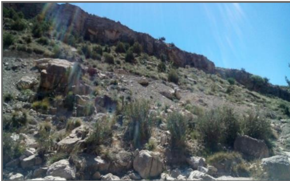
Photo 5 : Chute d'éboulis sur le versant Sud de Dj Chélia.
