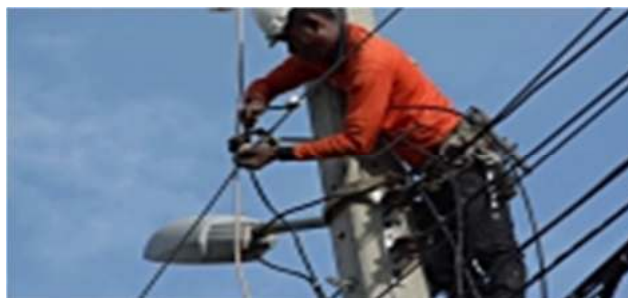
Figure III.1.3 Ouvrier travaillant sous tension.
