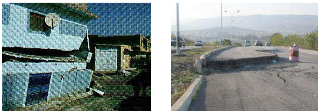
Figure 2.3 Effondrement de la ville de Cheria en 2009 et les dommages induits
