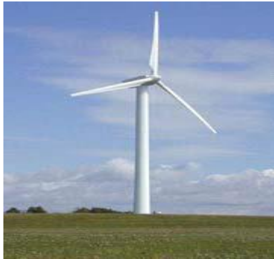
Figure. I.12 : Aérogénérateur à axe horizontal[6].
