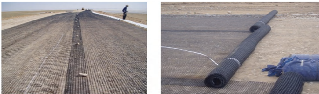
Figure 1-12 : Utilisation du géogridde dans le renforcement.
