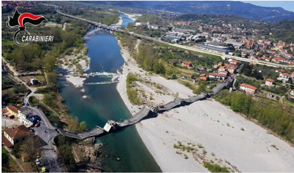
Photo.I.1. La destruction d'un pont à Aulla, en Italie en 2020.
