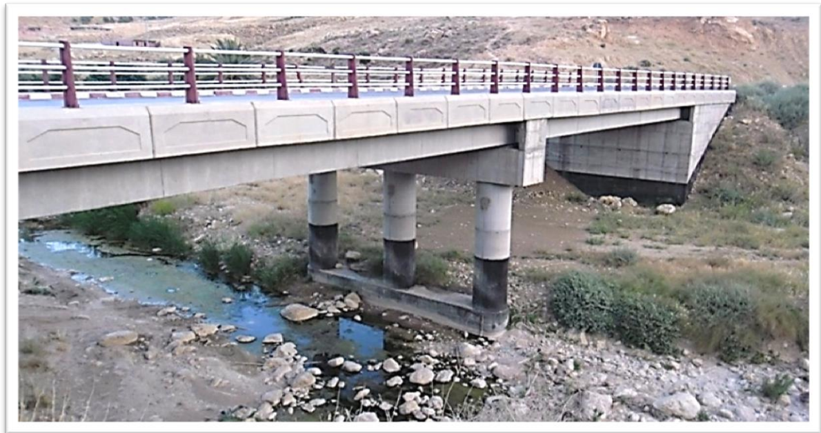
Photo. III. 5. pont à piles circulaire sur la RN 03, Pk : 254+000, commune Maafa
