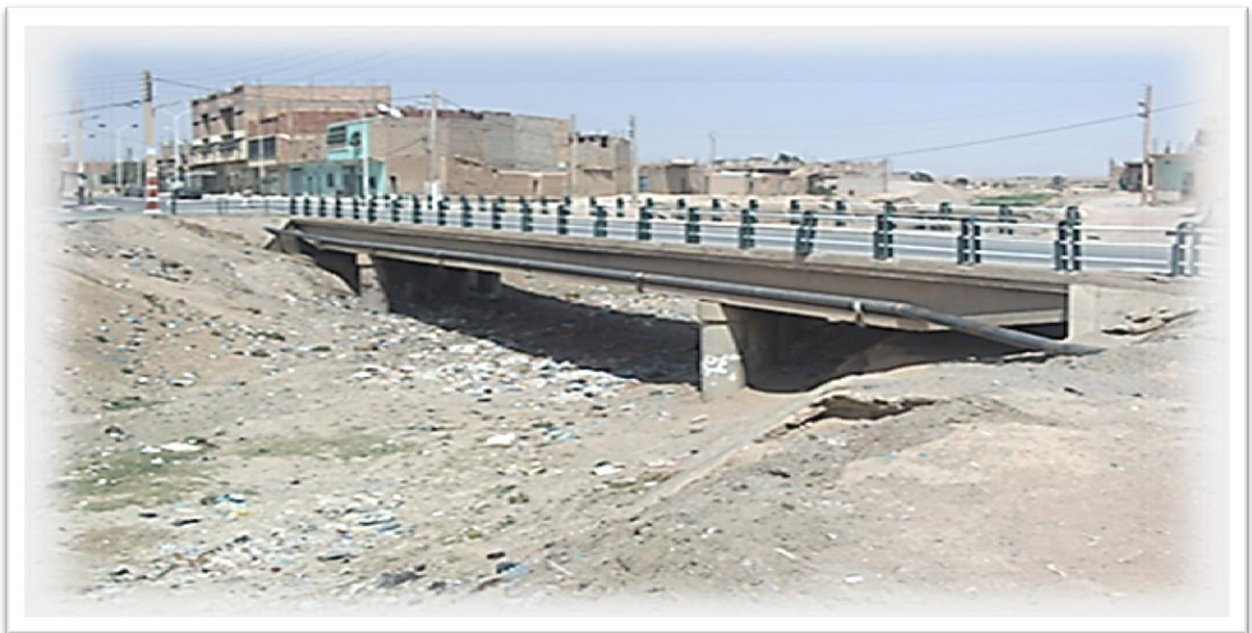
Photo. III. 4. Ouvrage d'art, pont mixte franchissant oued Barika RN78 Pk : 89+600
