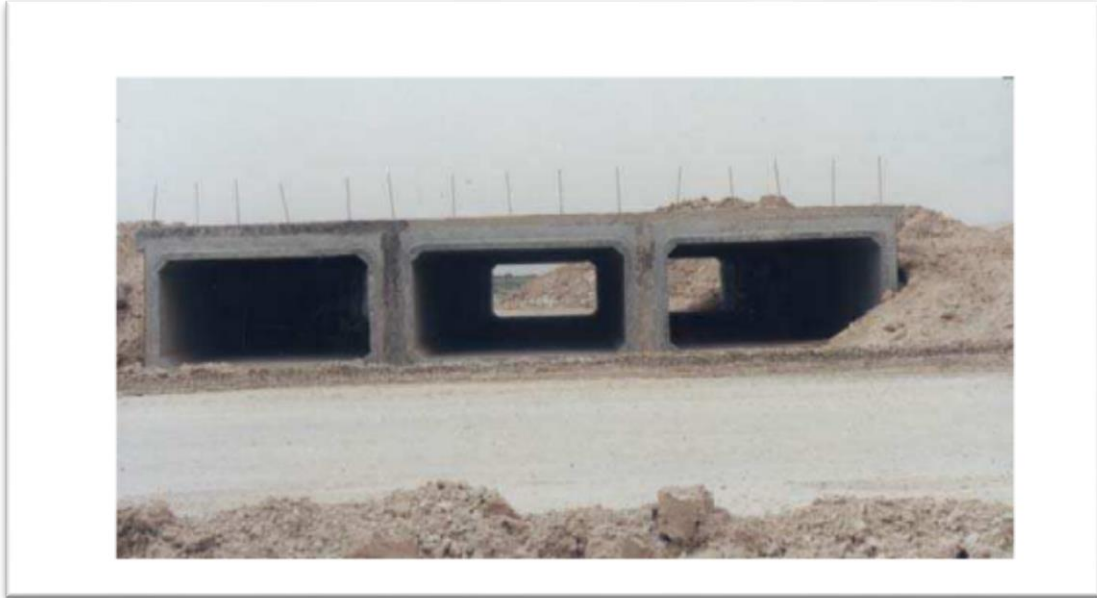
Photo. II. 12. Dalot triple préfabriqué en cours d'exécution.
