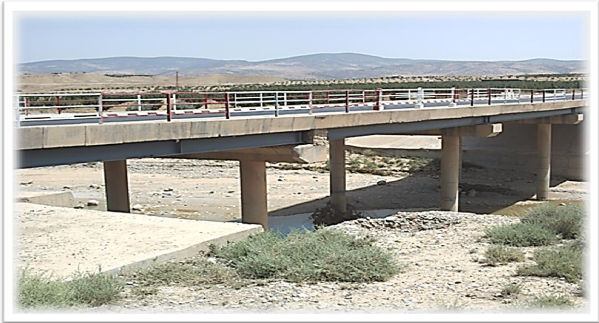
Photo. III. 6. Ouvrage d’art franchissant oued barika, Pk : 65+200
