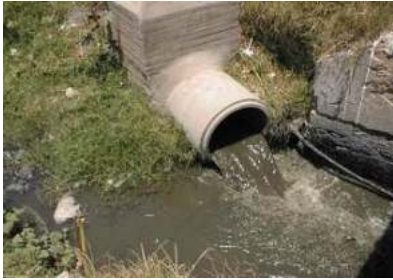
Photo N° 01: Les eaux usées déversés directement dans le milieu naturel
