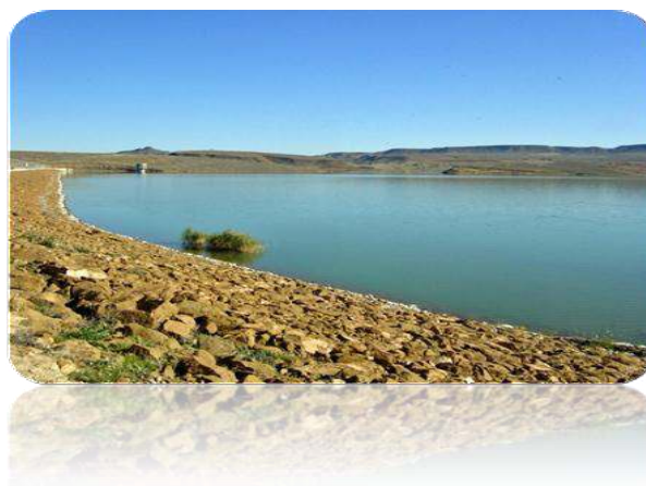
Photos (N° 2 et N° 3) Barrage de Koudiat Medouar
