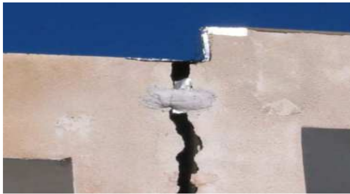
Fac-similé V.4 : Exemple type du basculement d'un bloc.
