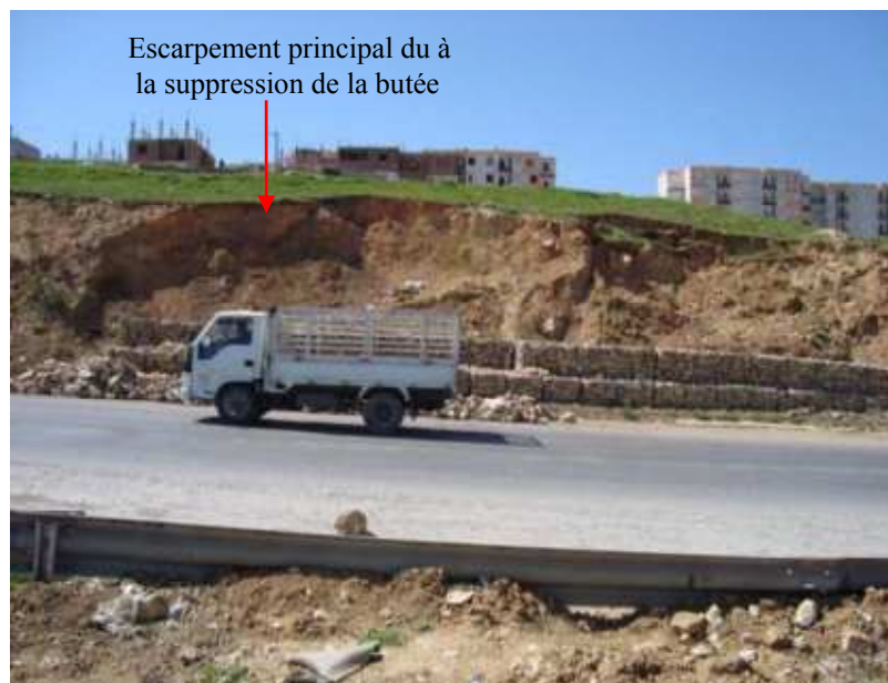
Fac-similé IV.1 : loupes de solifluxion et foîrage en paquet dans un versant.
