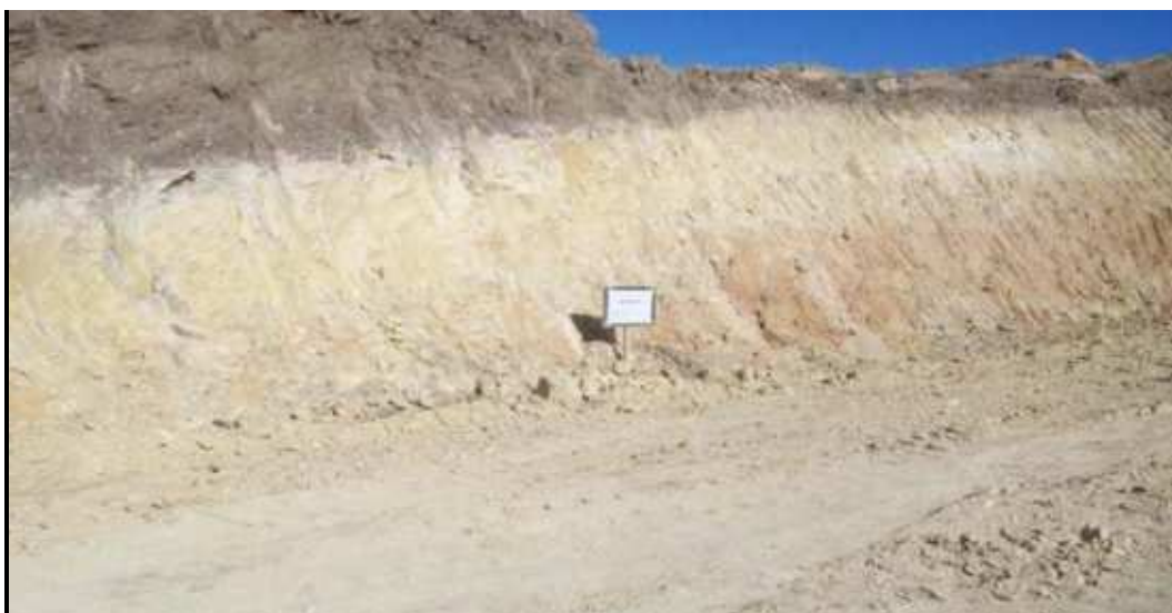
Photo A.1 : Zone de déblais PK 197+370 constantine, comp3
