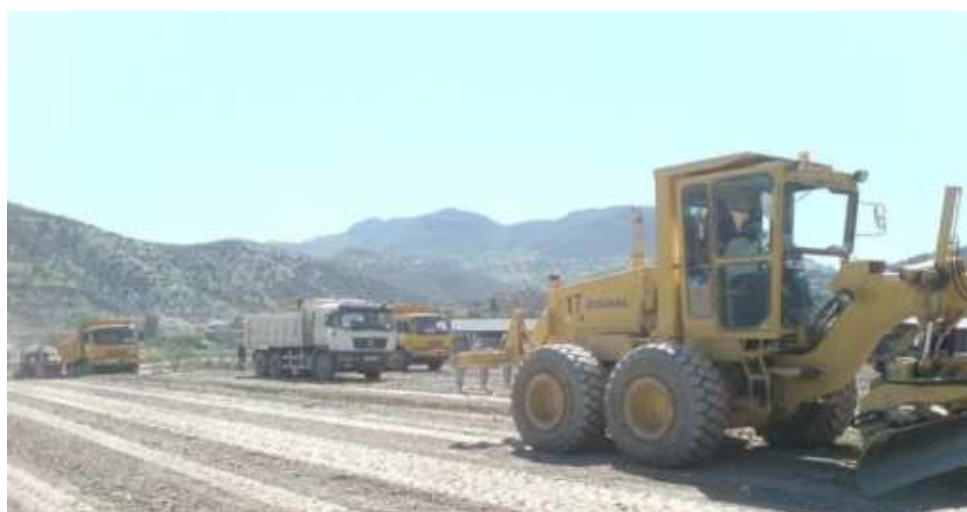
Photo A.6 : exécution de remblai, Harrouche, comp5
