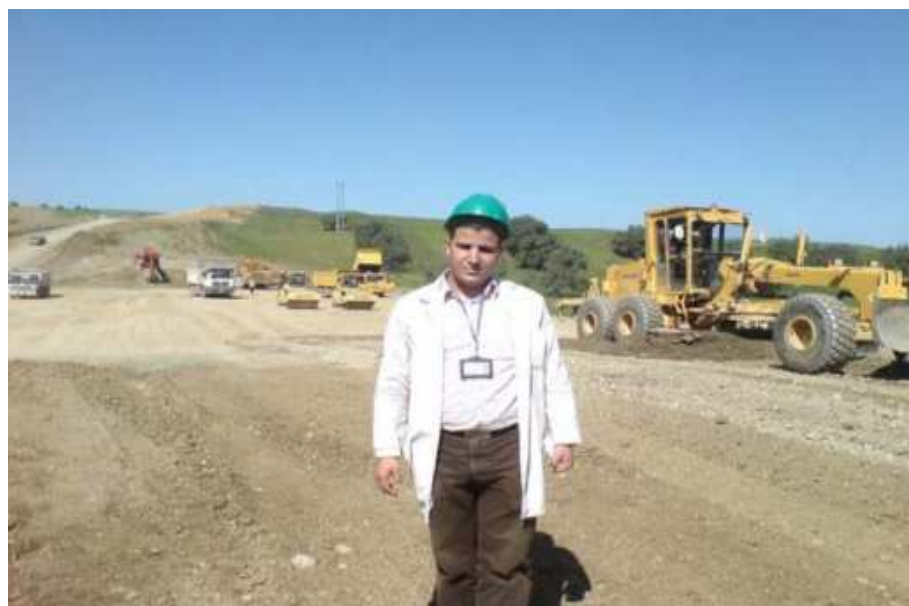
Photo A.5 : section remblai, Harrouche, comp5
