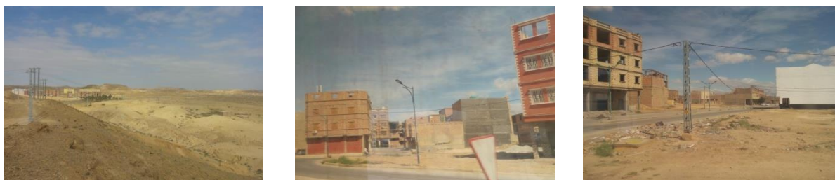
Figure 55. Absence d'éléments de visibilité et de structuration de l'espace urbain
